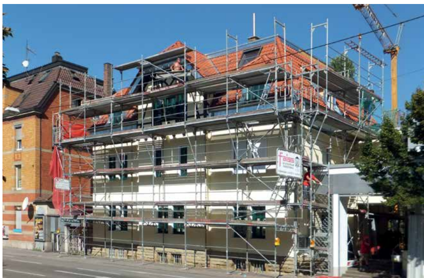
Priorat Stuttgart während der Renovierungsarbeiten
